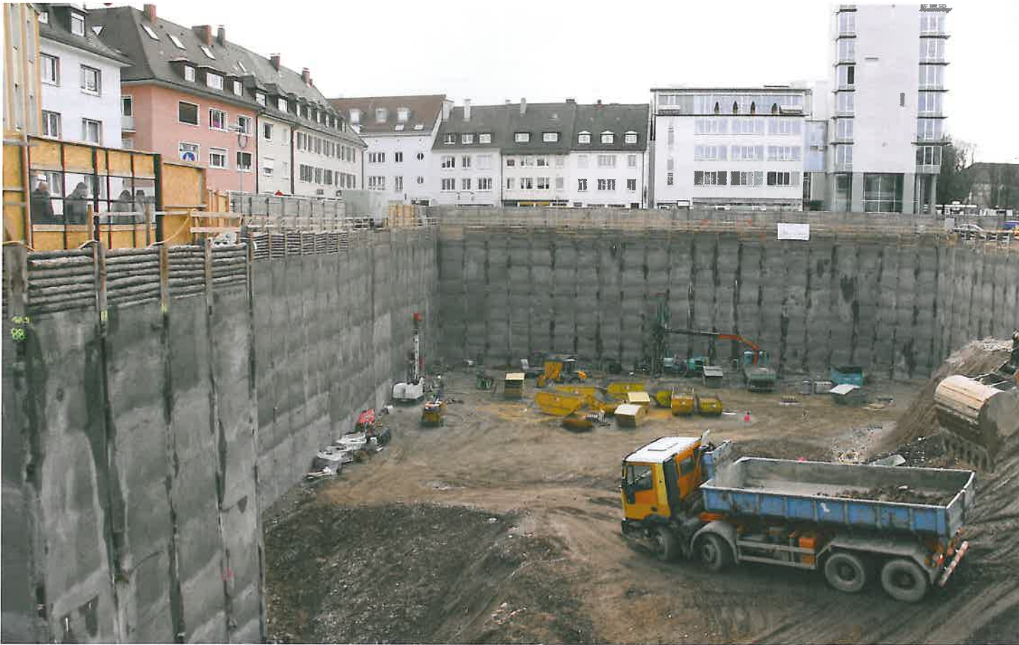
Abb. 2 Übersicht über die Baustelle „Quartier Unterlinden“ im Zentrum von Freiburg
