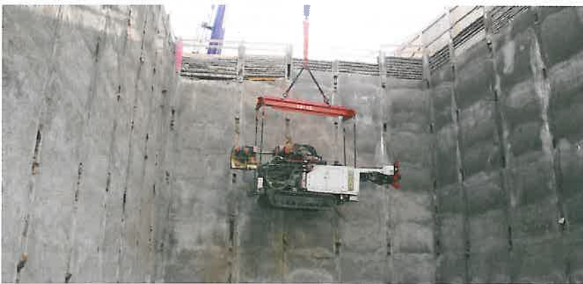
Abb. 3 Nach Abschluss der Arbeiten wurden die Anlagen per Kran aus der Baugrube gehoben.
