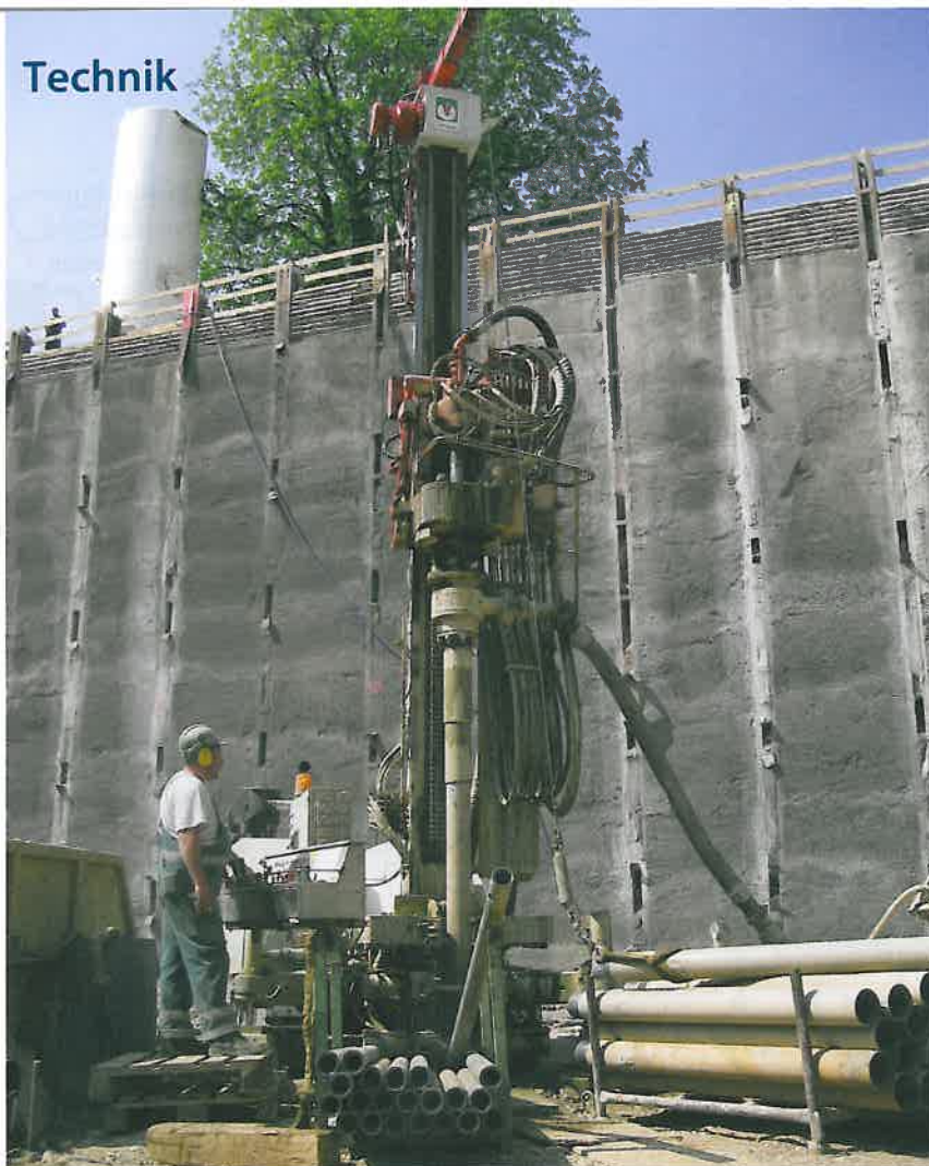
Abb. 1 Die mobile Vertikalbohranlage VB10 von Herrenknecht in der Baugrube
